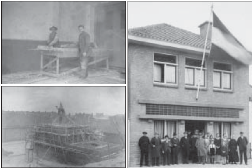
Het vergaderlokaal aan de Vissershavenstraat in Scheveningen tijdens de bouw (links) en tijdens de opening op 18 mei 1931 (rechts).
