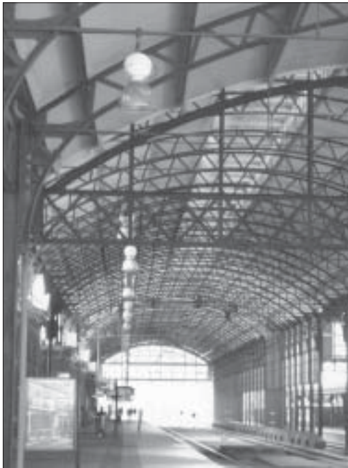
De overkapping van het station Hollandse Spoor.
